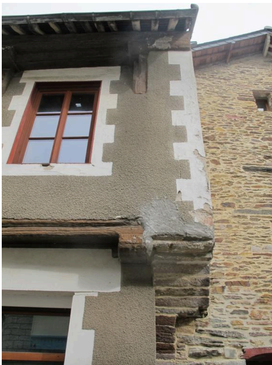
Façade nord. Premier étage, partie ouest
