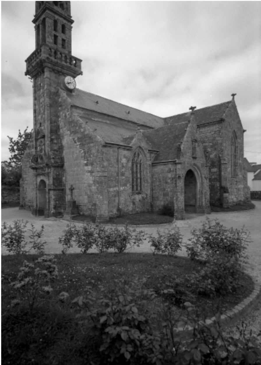
Quéménéven, église paroissiale Saint-Ouen : vue générale sud-ouest, état en 1972
