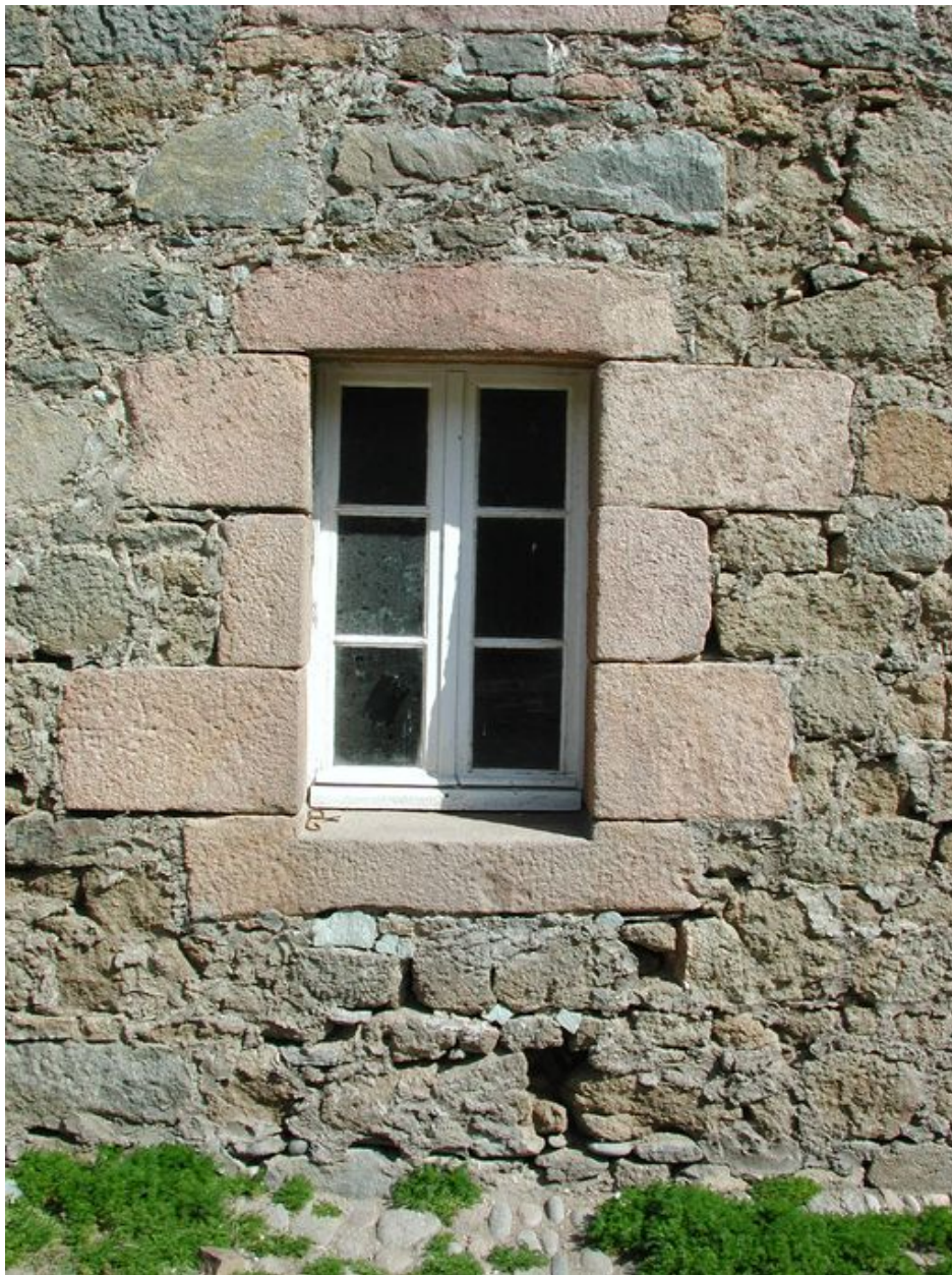
Vue de l'élévation sud : encadrement en pierre de taille de granite rose de l'une des fenêtres (état en 2002)
