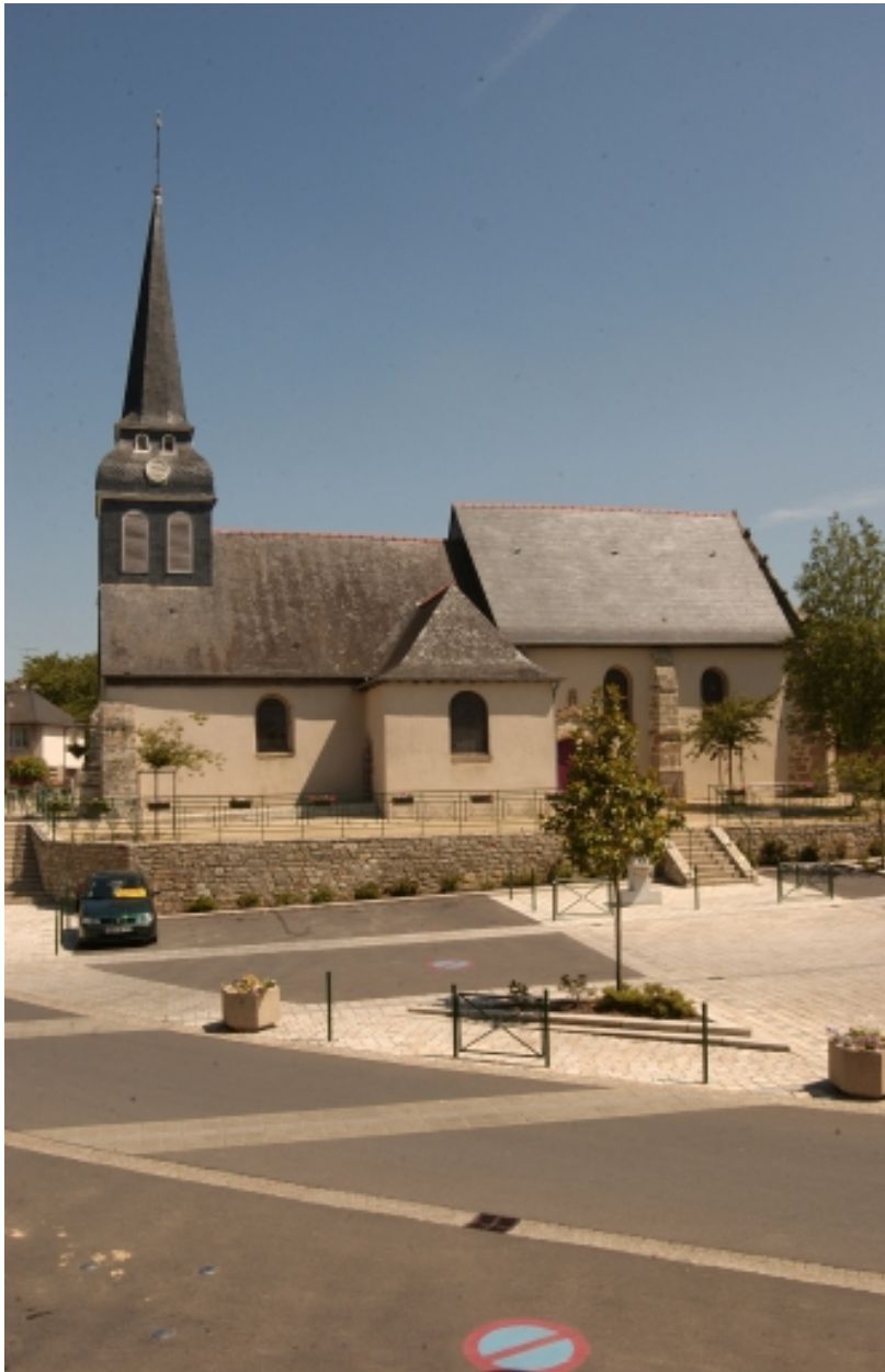
Elévation sud : vue générale
