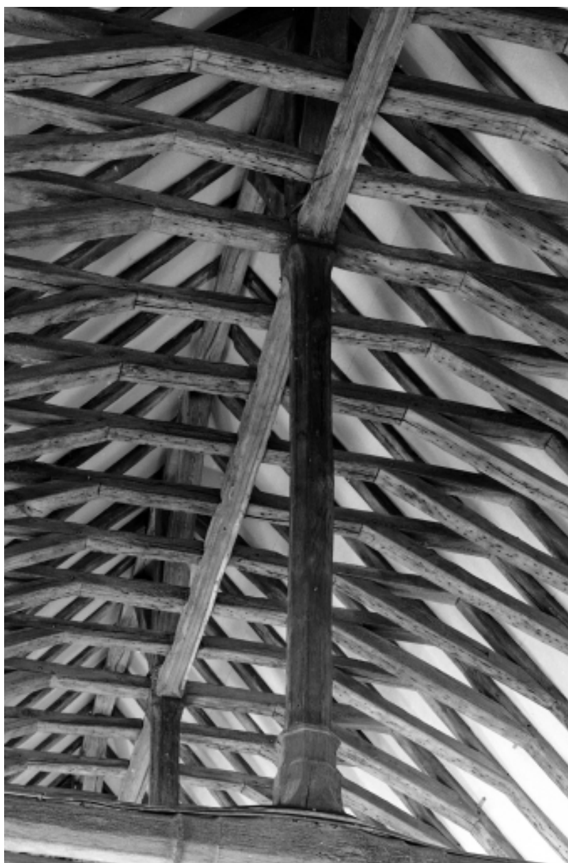
Intérieur, nef, charpente : vue générale.
