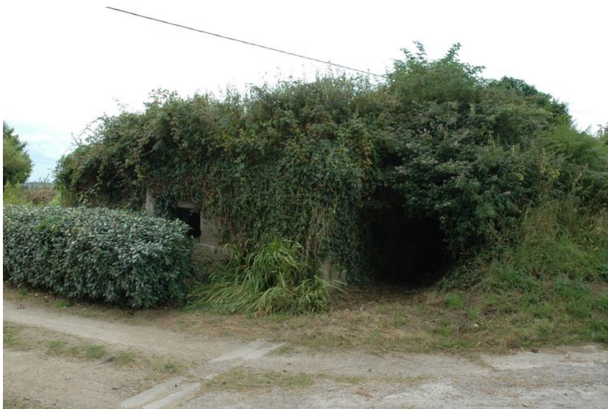
Vue de l'un des bunkers (état en 2008)
