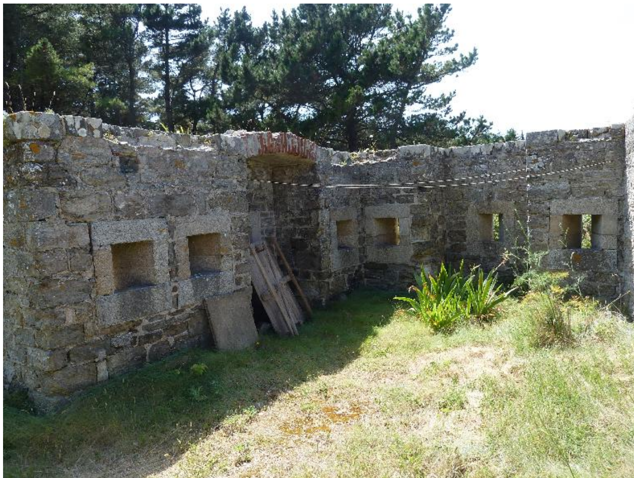
Le Palais, batterie du Gros Rocher, fossé de gorge, bastionnet de flanquement avec bretèches.
