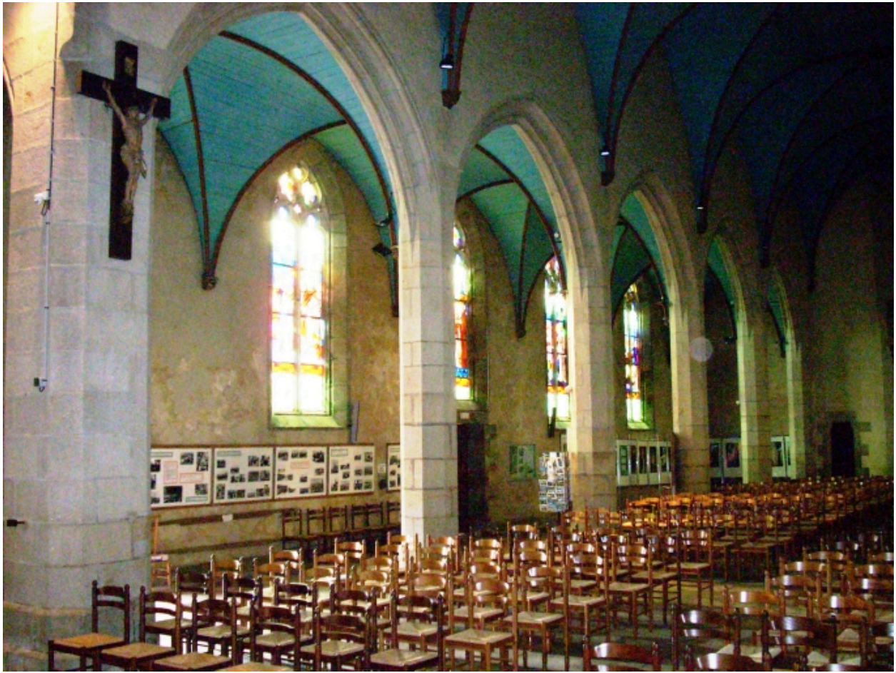
Plonévez-Porzay, chapelle Sainte-Anne-La-Palud : vue transversale sud-ouest
