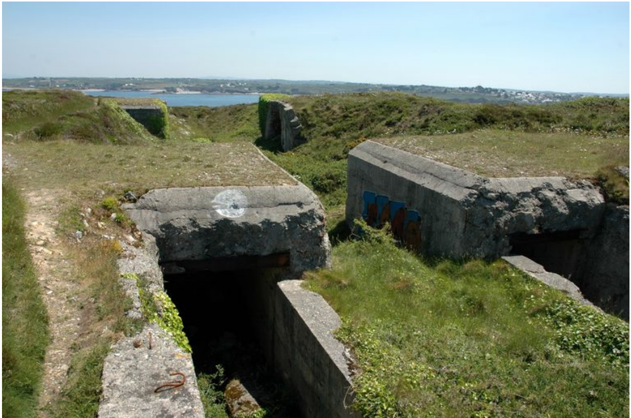
Vue de l'une des cuves pour canon de 22 cm (état en 2005). De part et d'autre de la rampe d'accès du canon, les magasins de munitions
