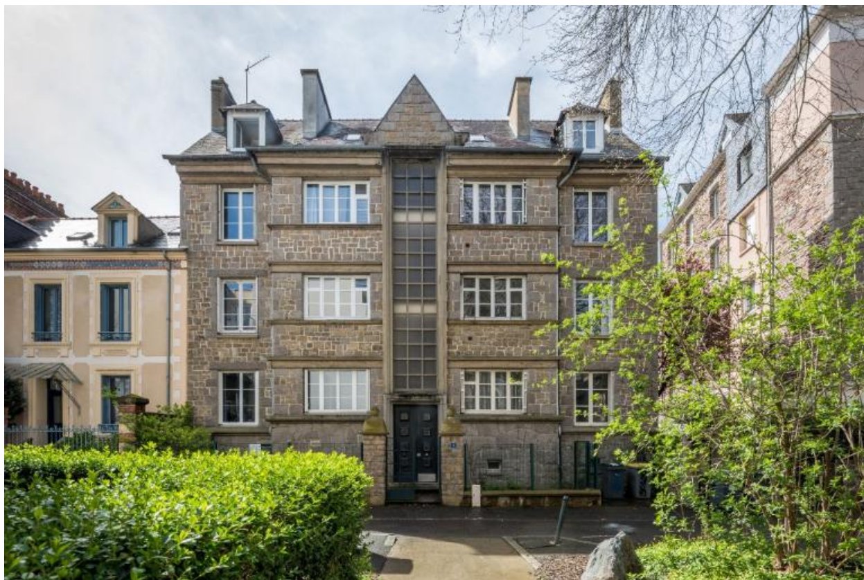
Immeuble de rapport, 2 rue du Père-Janvier. Vue générale de la façade antérieure orientée au nord.
