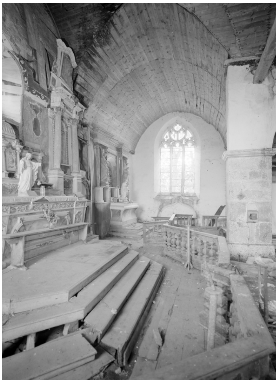
Vue générale du bas-côté sud
