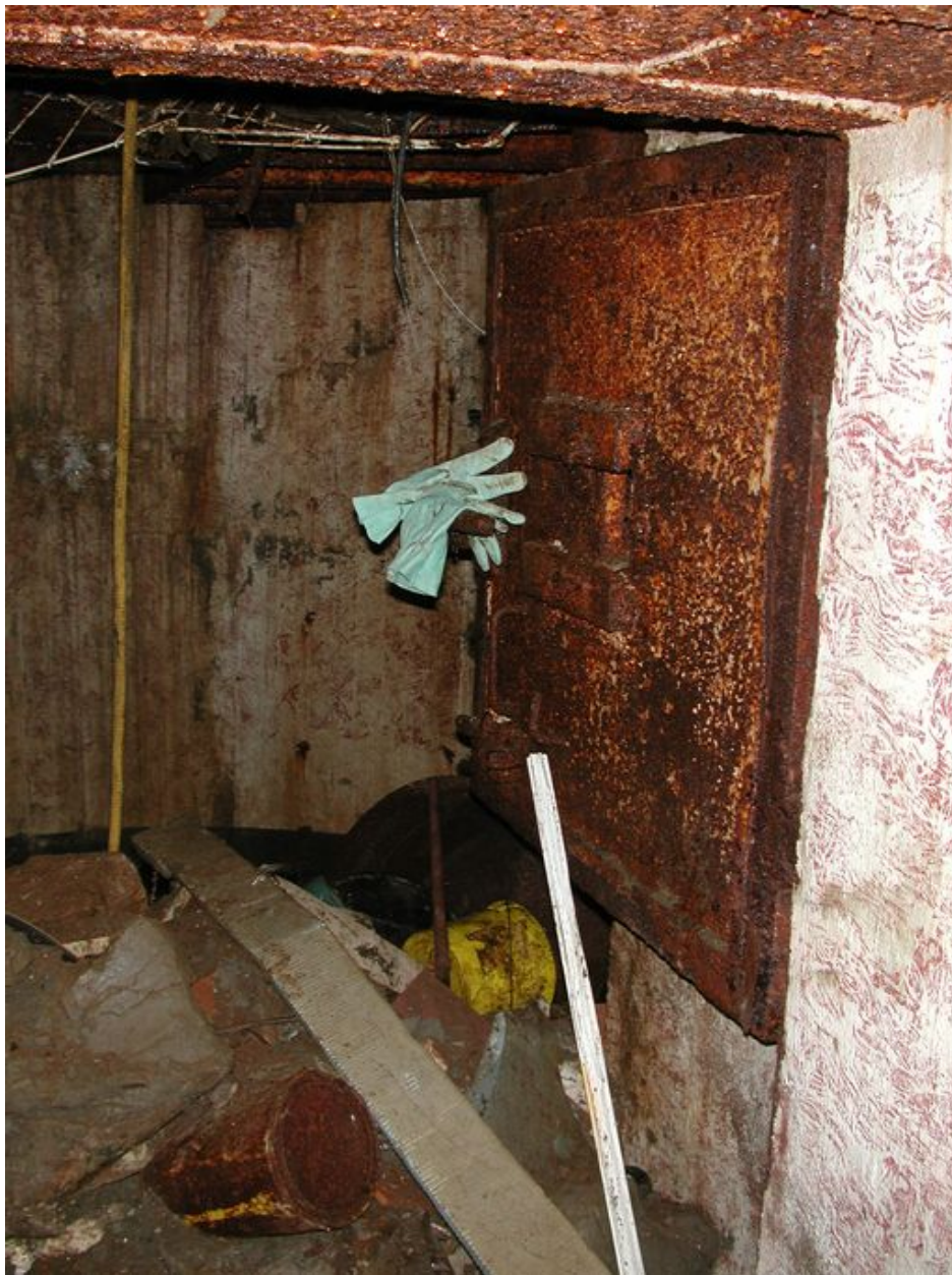
Vue du bas du puits de la cloche blindée (état en 2003)
