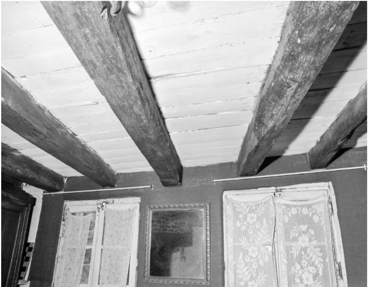
Poutraison et parquet à l'étage, en partie ouest (1978).
