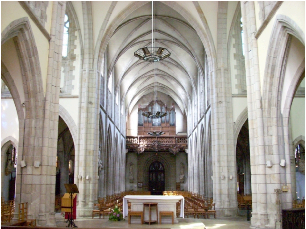
Quimper, église Saint-Mathieu : vue axiale ouest depuis le chœur
