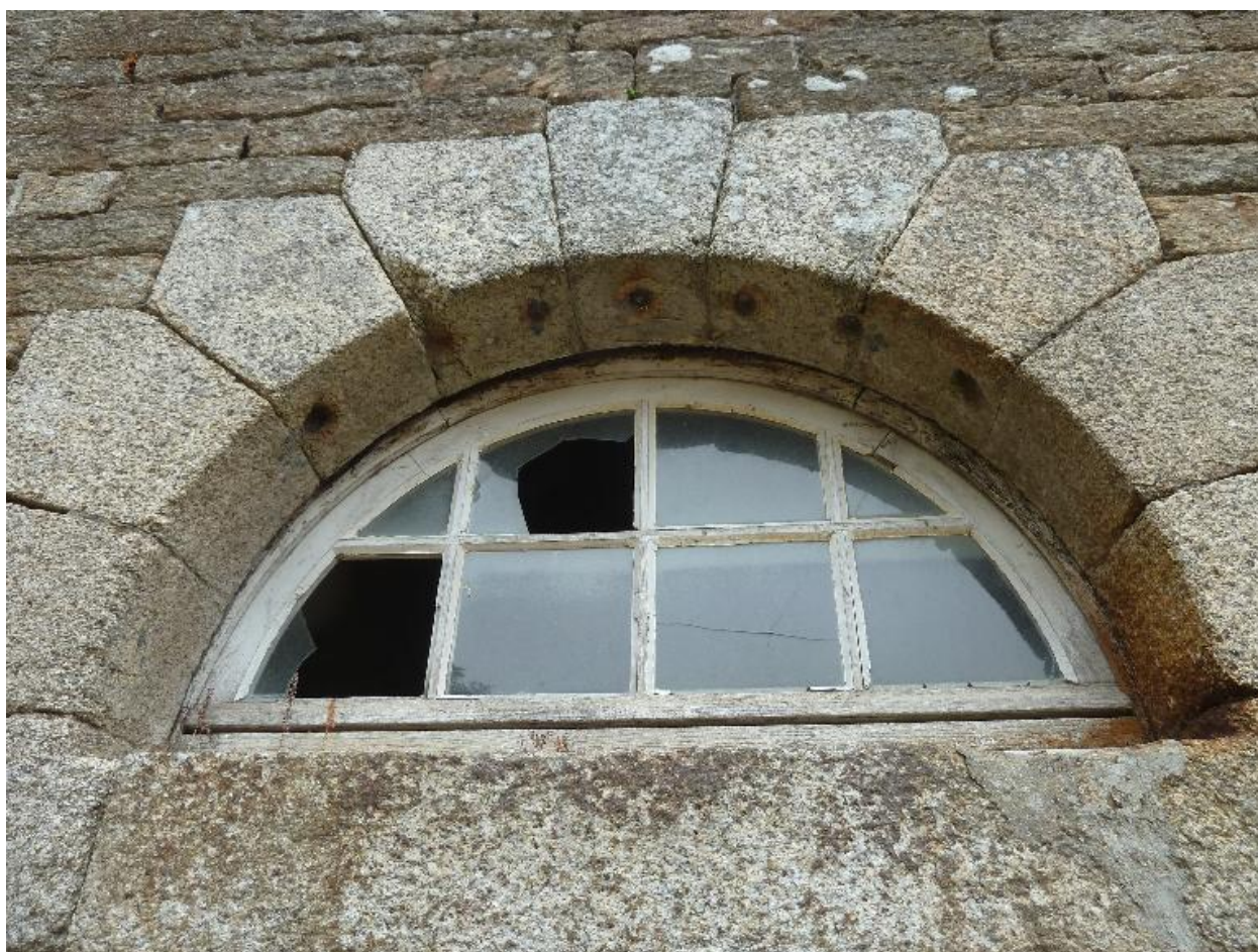
Groix, batterie du Gripp, corps de garde crénelé, détail d'une baie.
