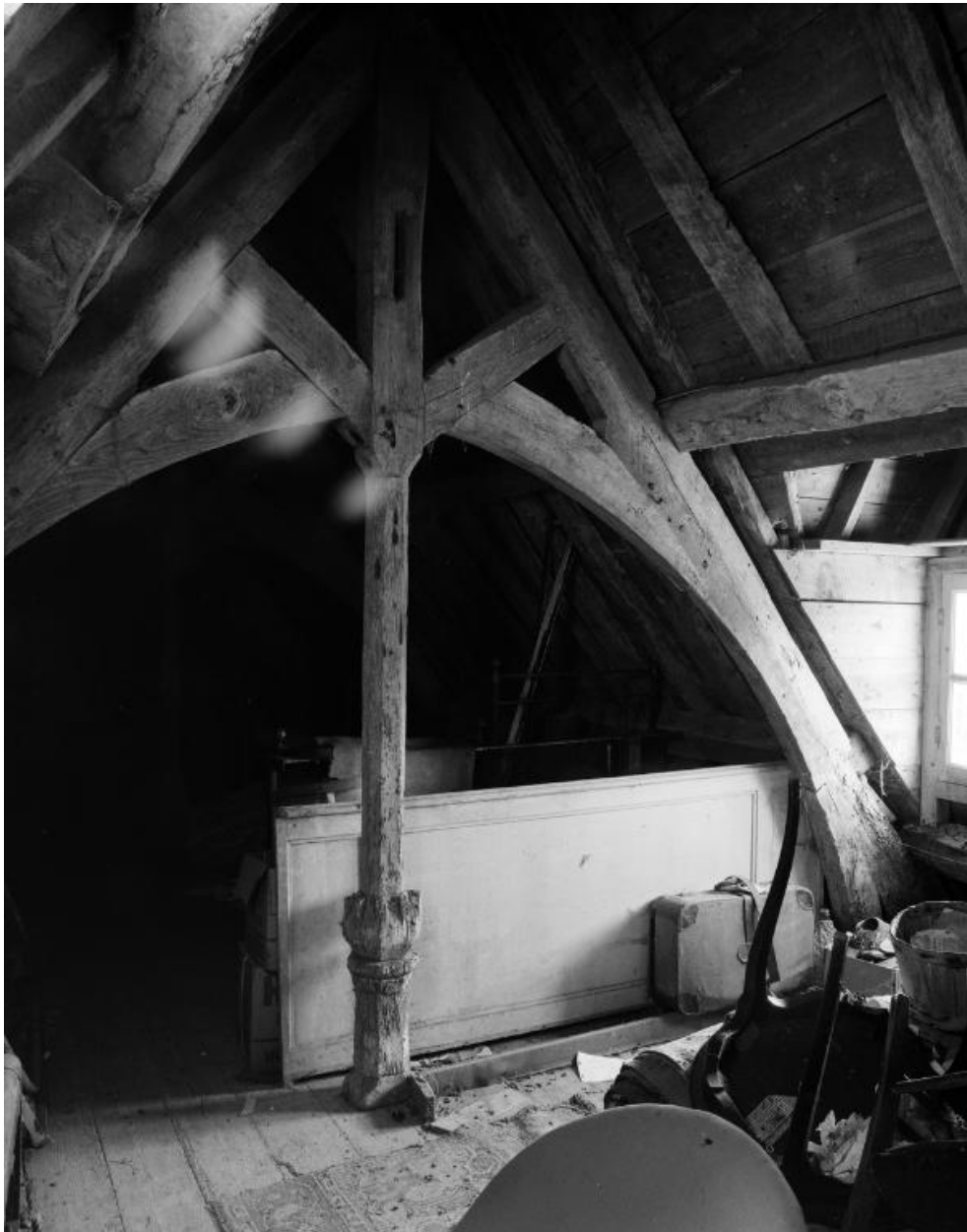
Corps central, charpente, vue générale
