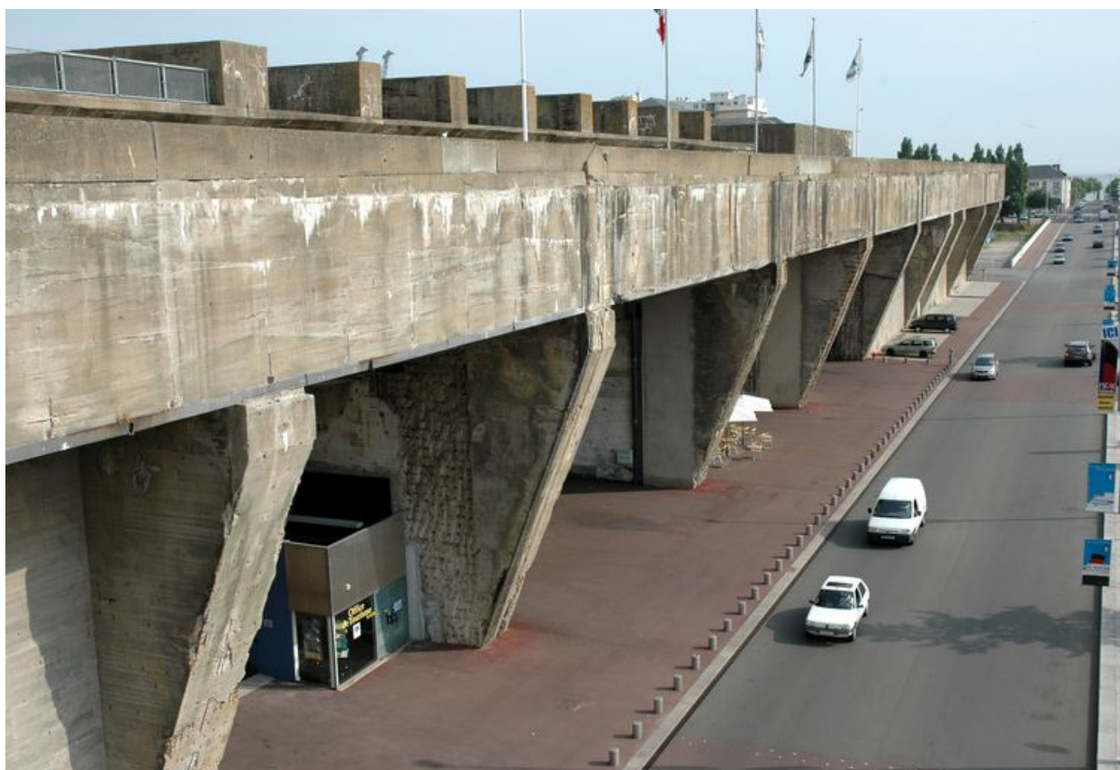
Vue générale de la base de sous-marins de Saint-Nazaire
