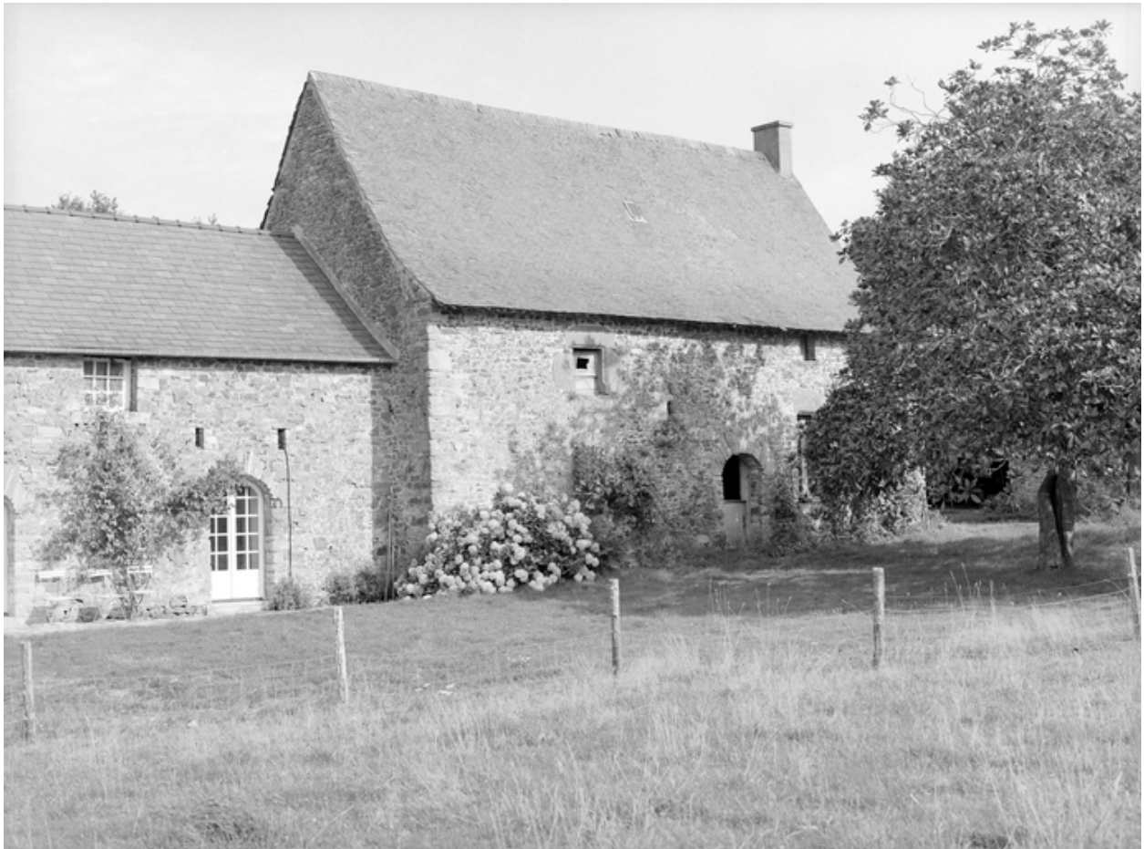
Ferme, vue générale du sud-est.
