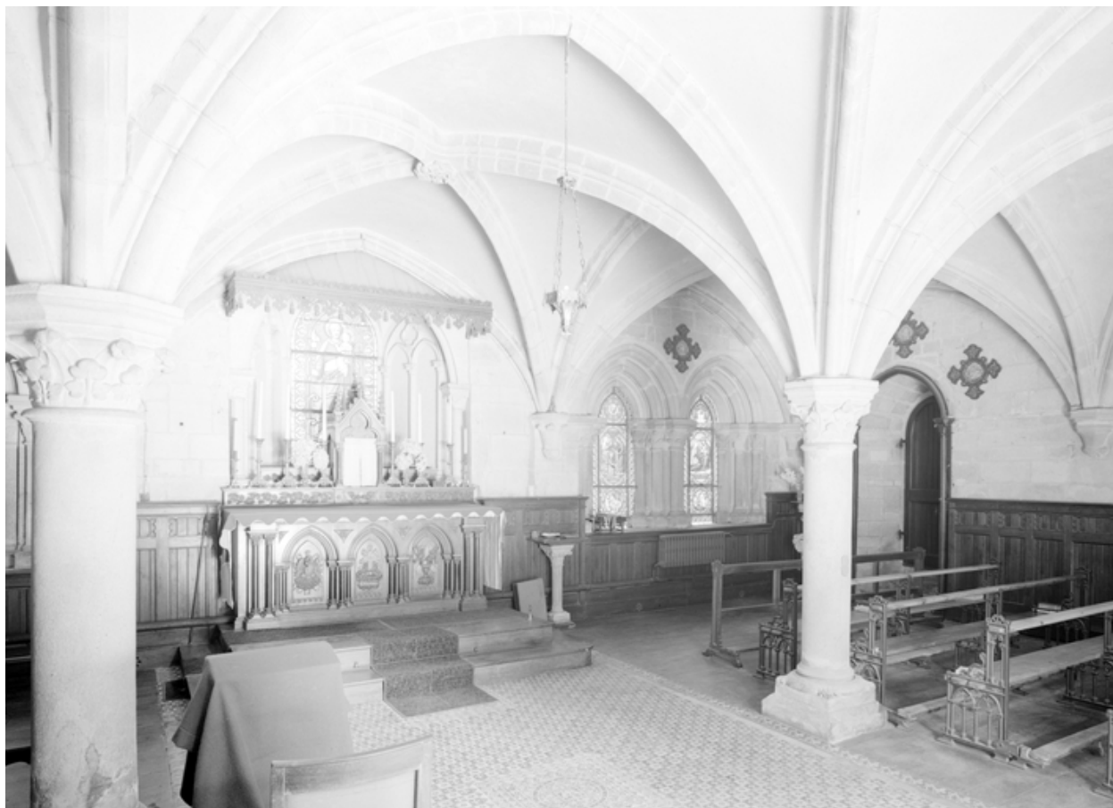
Corps de bâtiment D, salle capitulaire, piles (1965)
