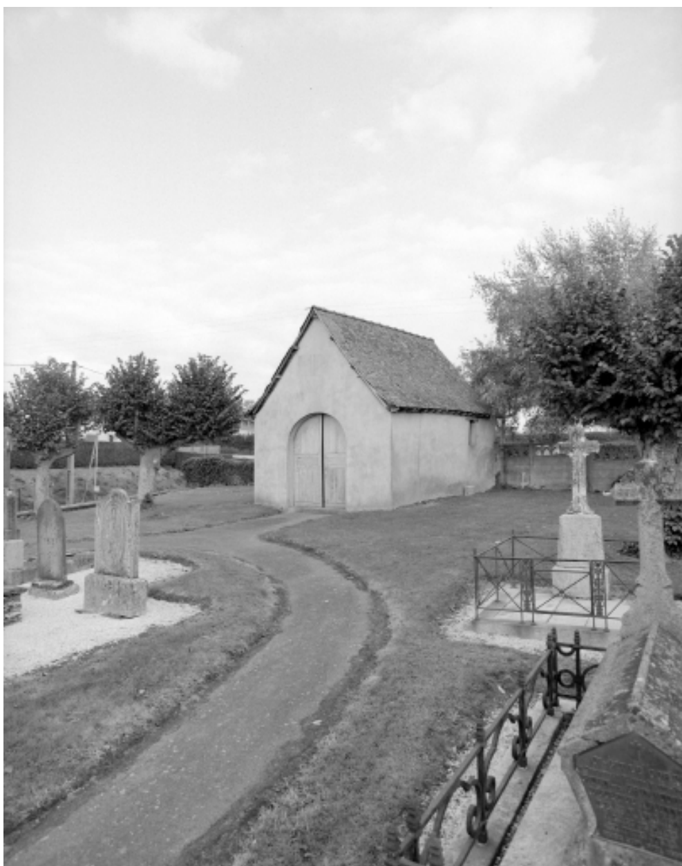
Elévation Sud-Ouest : vue générale
