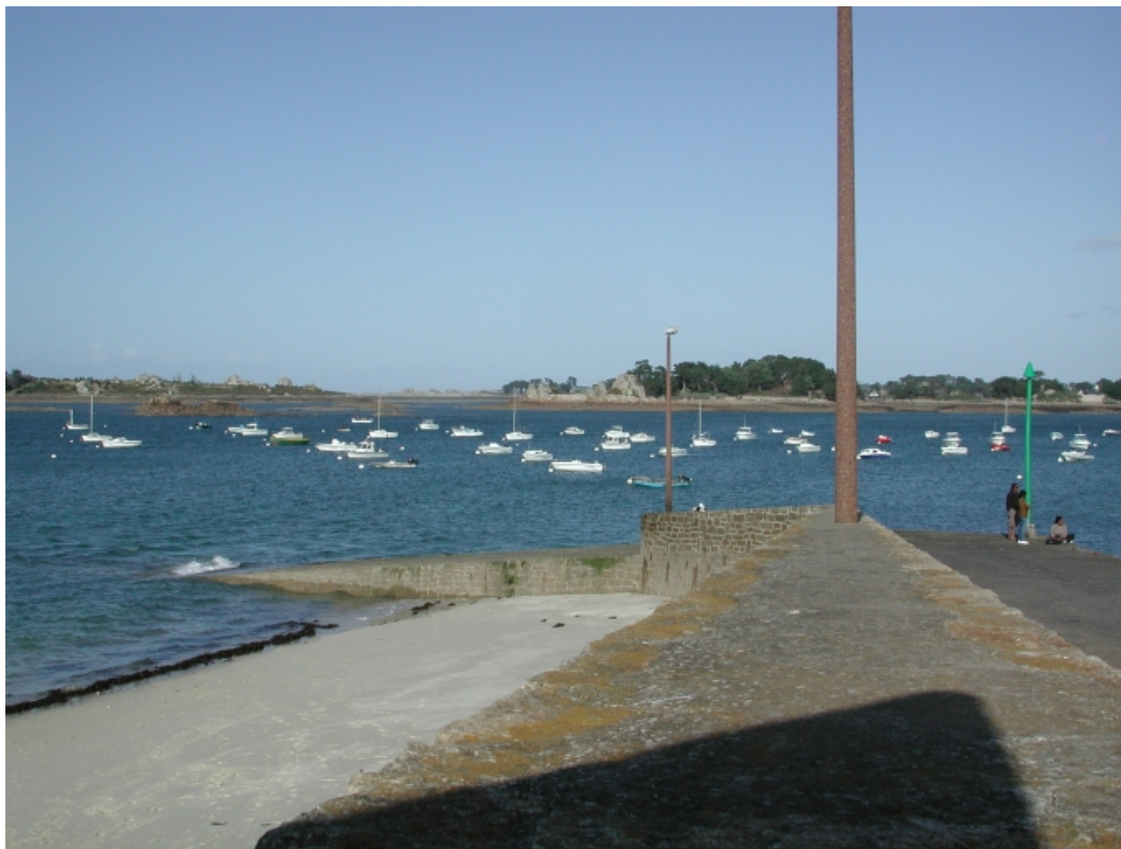
Vue du parapet de la jetée
