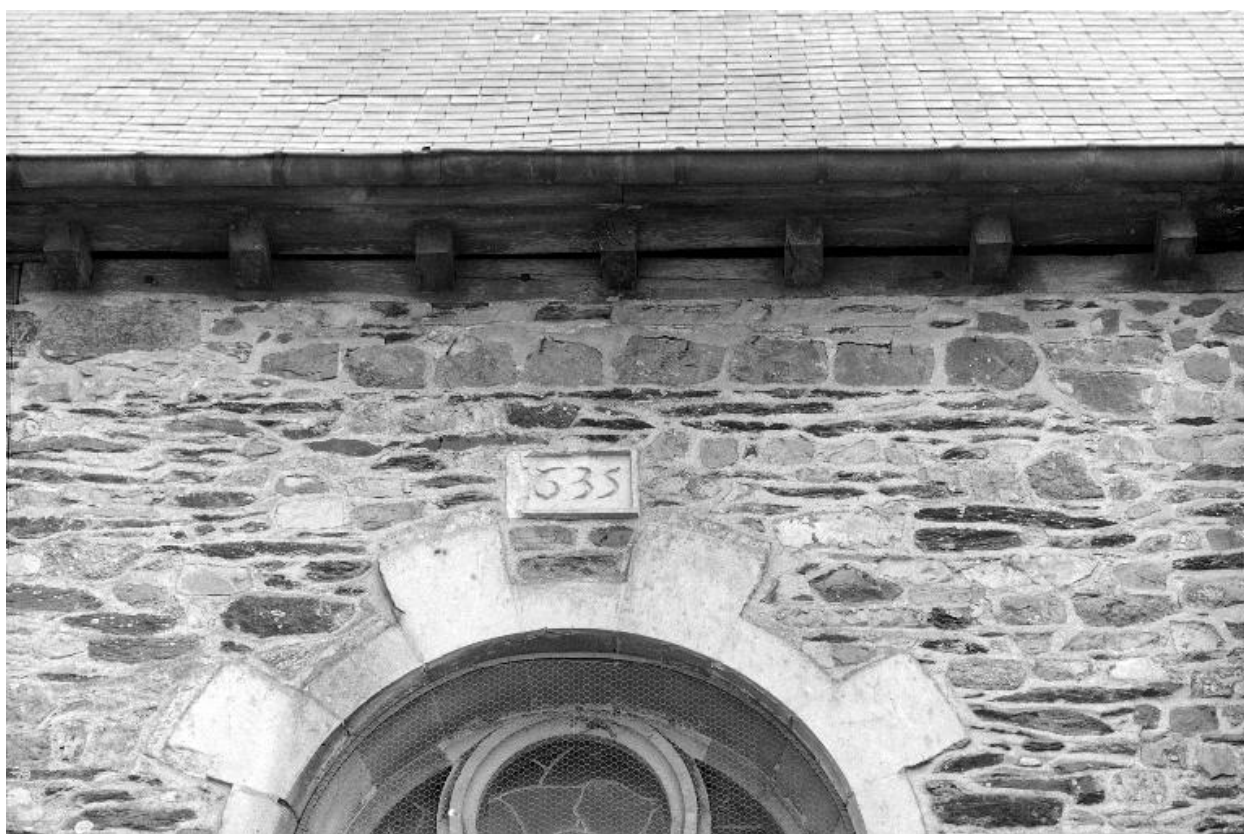
Façade nord, fenêtre datée, vue de détail (Etat en 1968)
