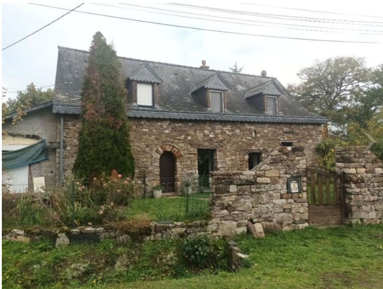
Façade avec porte à larmier, 3 la Gandouflais
