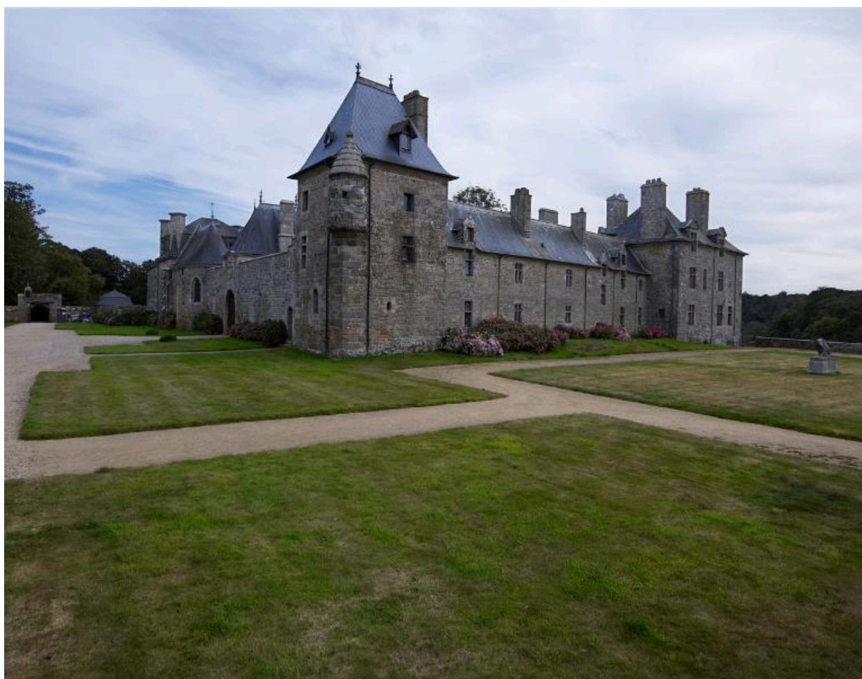
Vue générale depuis le nord
