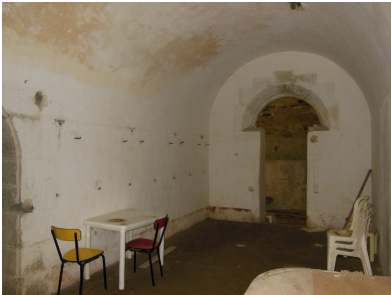
Le Palais, batterie du Gros Rocher, corps de garde crénelé, chambrée de troupe.
