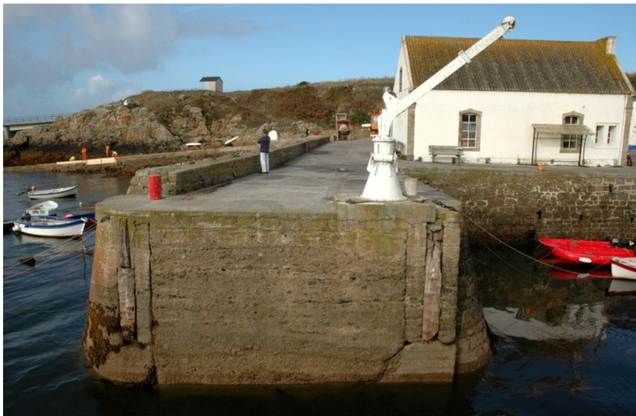
Vue du port-abri de Lampaul
