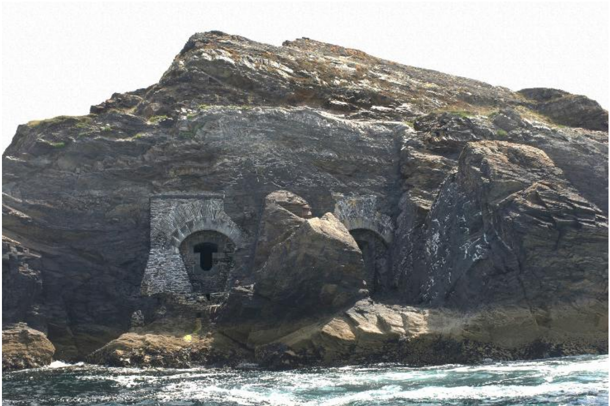
Roscanvel : vue de l'ensemble fortifié de l'îlot des Capucins depuis la mer, face nord, batterie de rupture, embrasures
