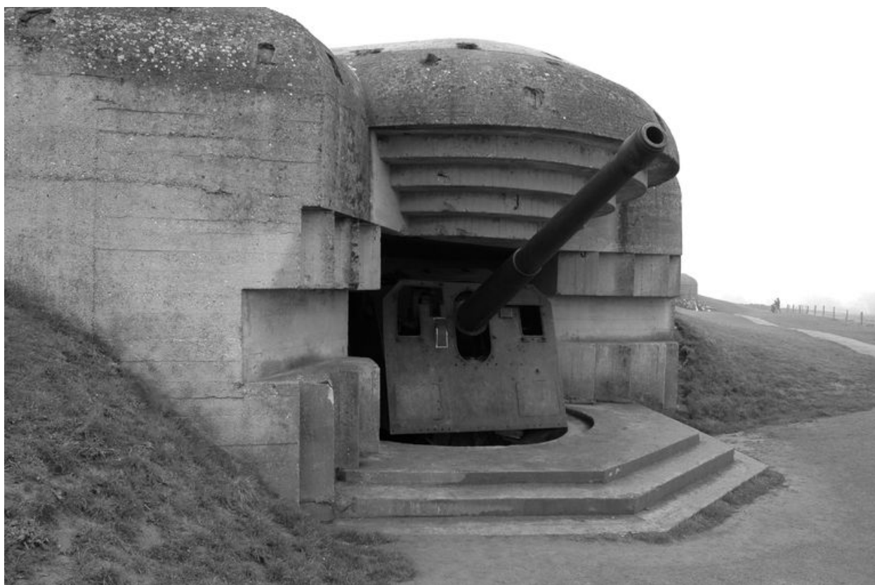
Vue générale de l'une des quatre casemates de la batterie de Longues-sur-Mer (casemate n° 3 depuis l'est)
