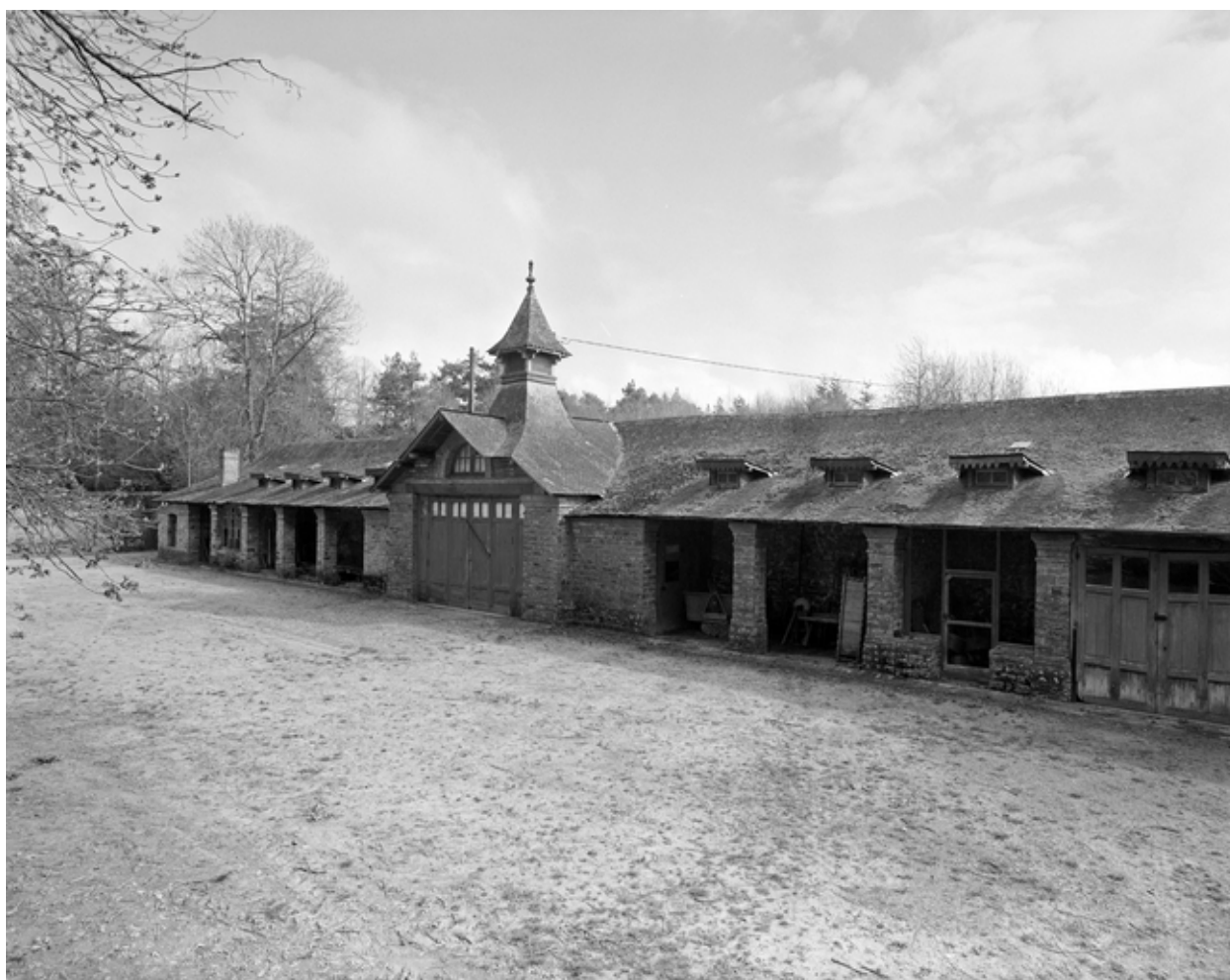
Vue générale des anciennes remises.
