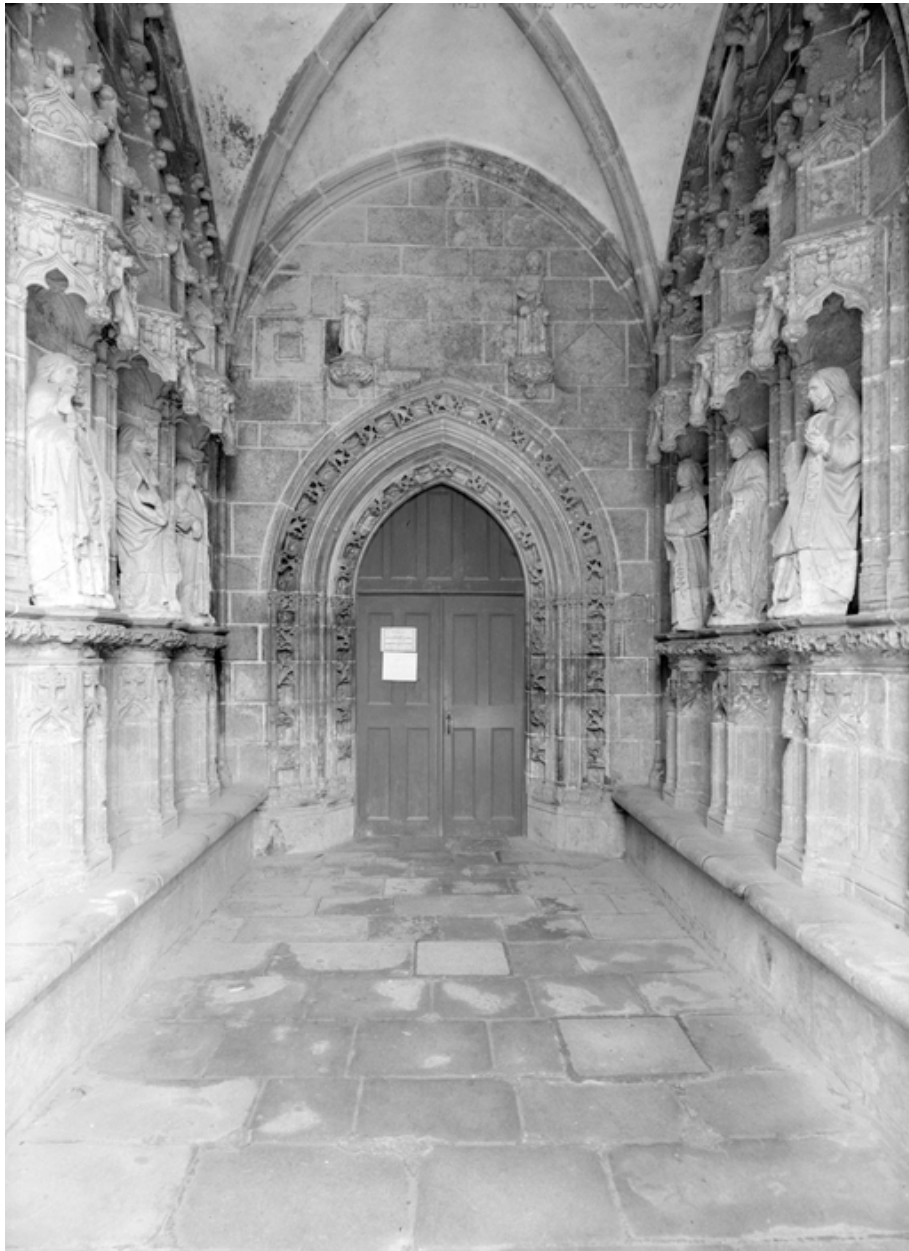
Porche sud de la nef, vue axiale.
