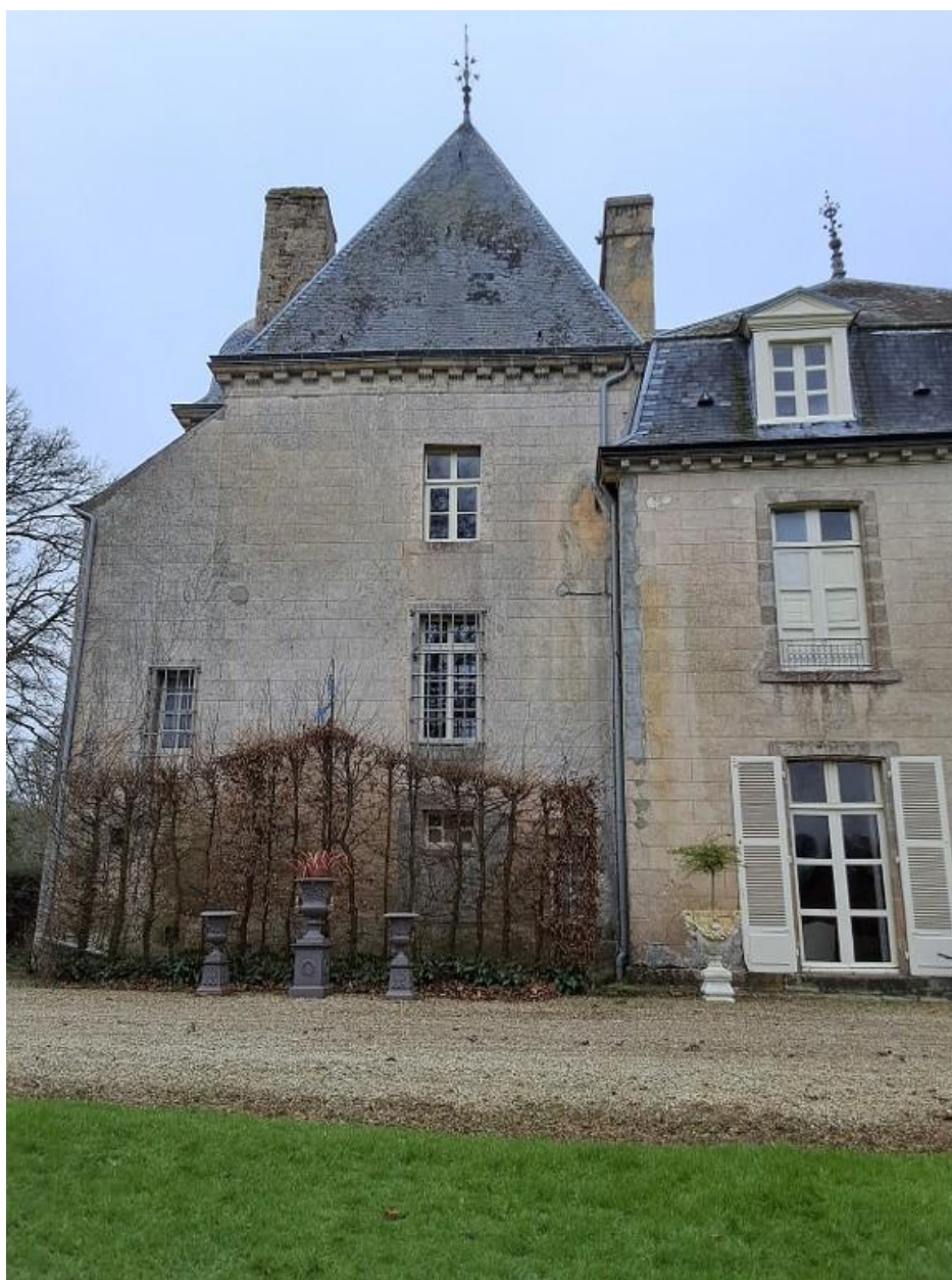
Pavillon Renaissance, façade est
