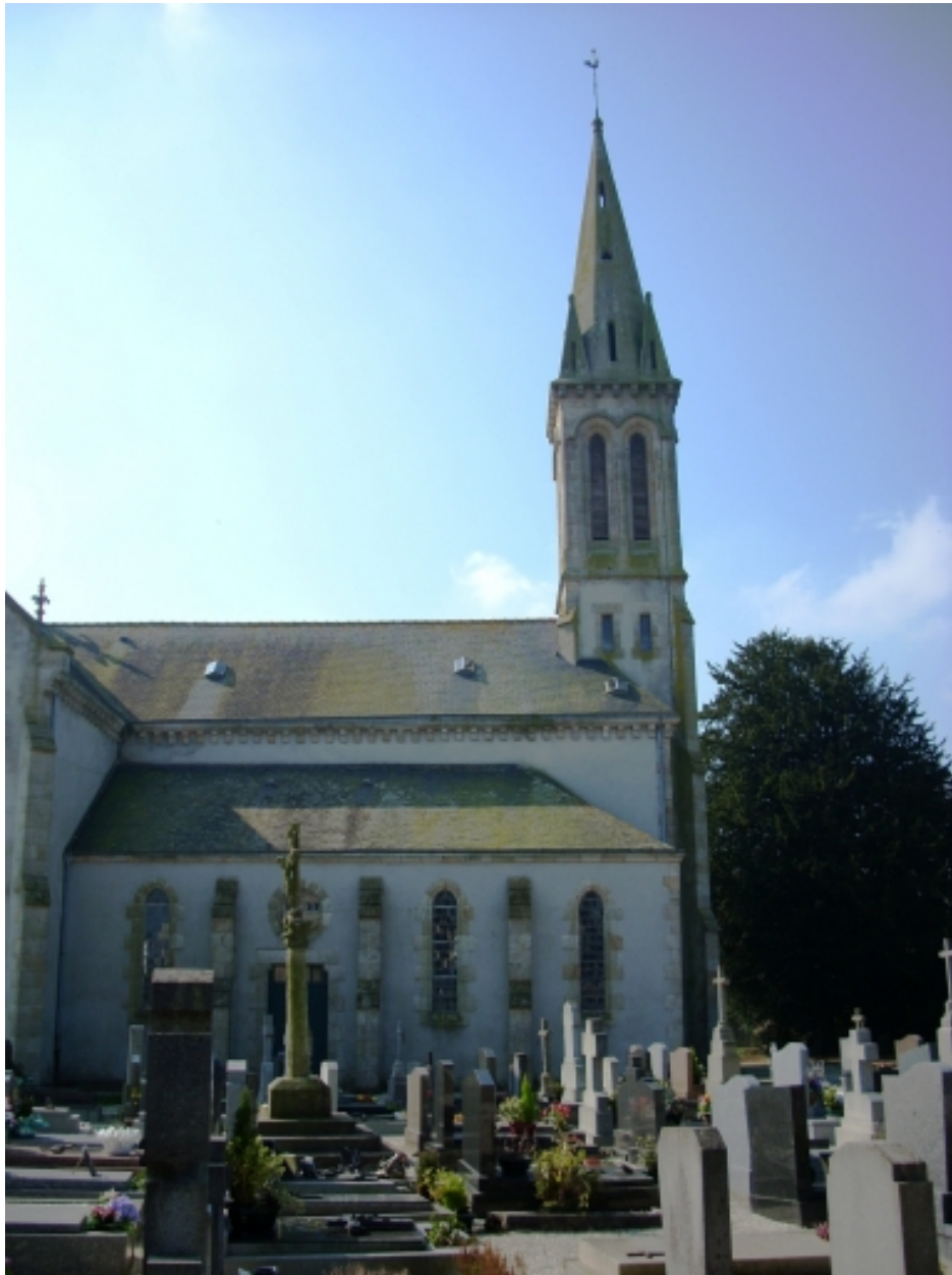
Lothey, église paroissiale Saint-Fiacre : vue générale nord
