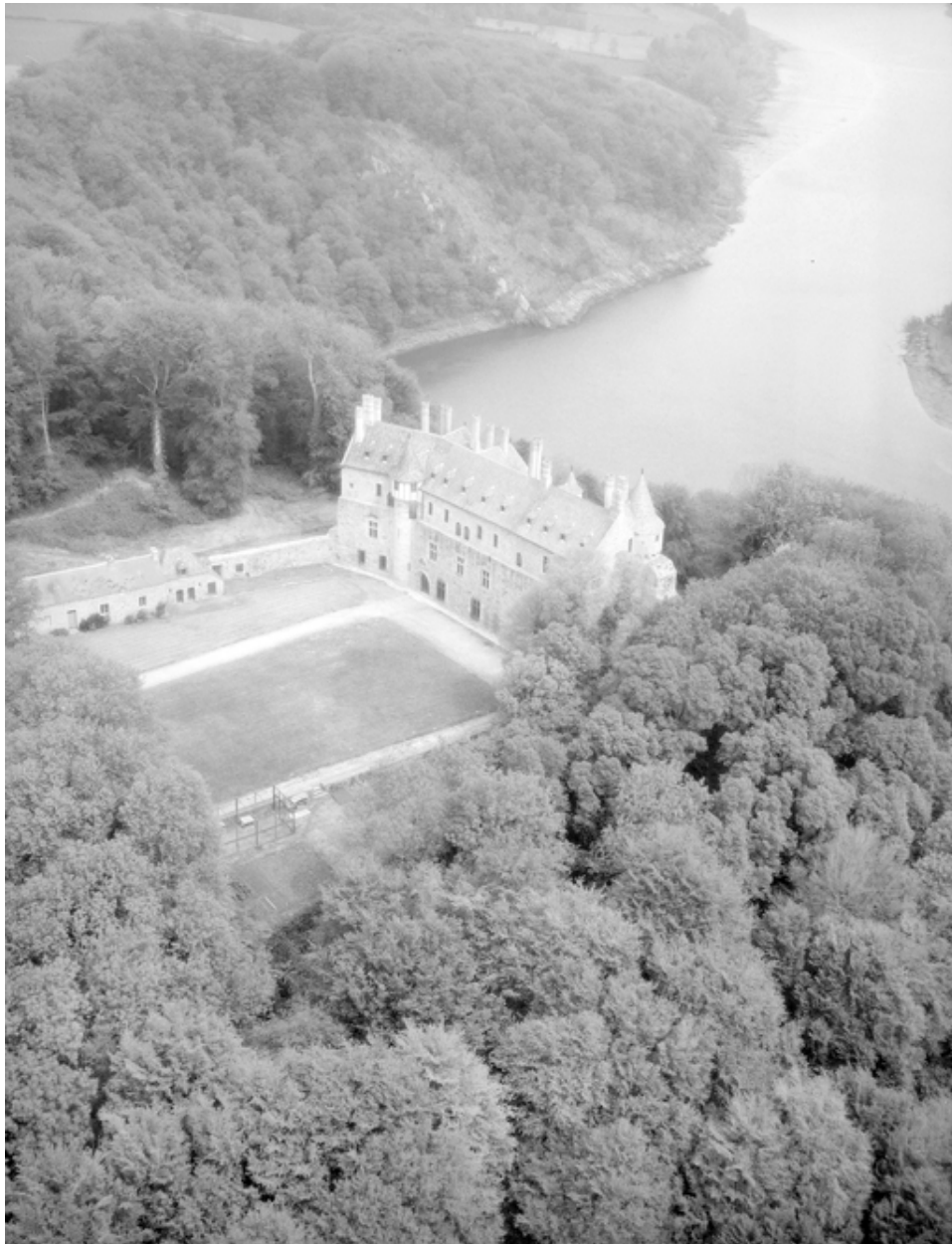
Vue aérienne oblique depuis le sud (état en 1977)
