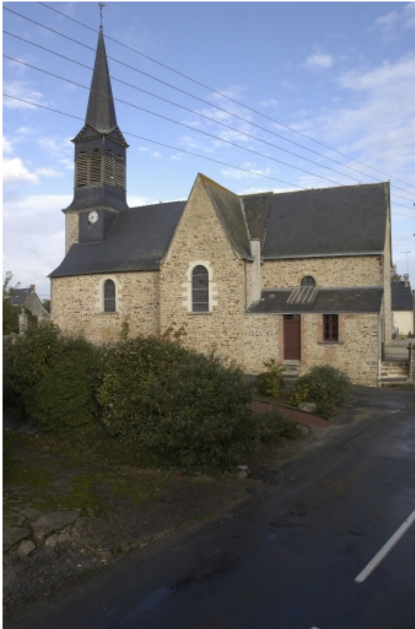
Vue générale sud de l'église
