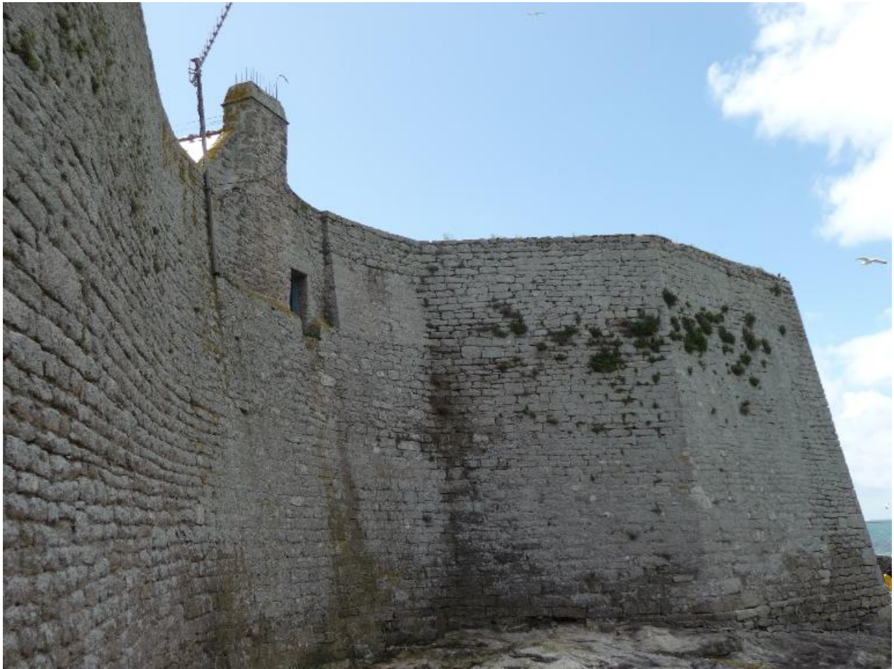
Vue muraille nord-est avec pignon maison des officiers - fenêtre et cheminée - Cigogne - mai 2014
