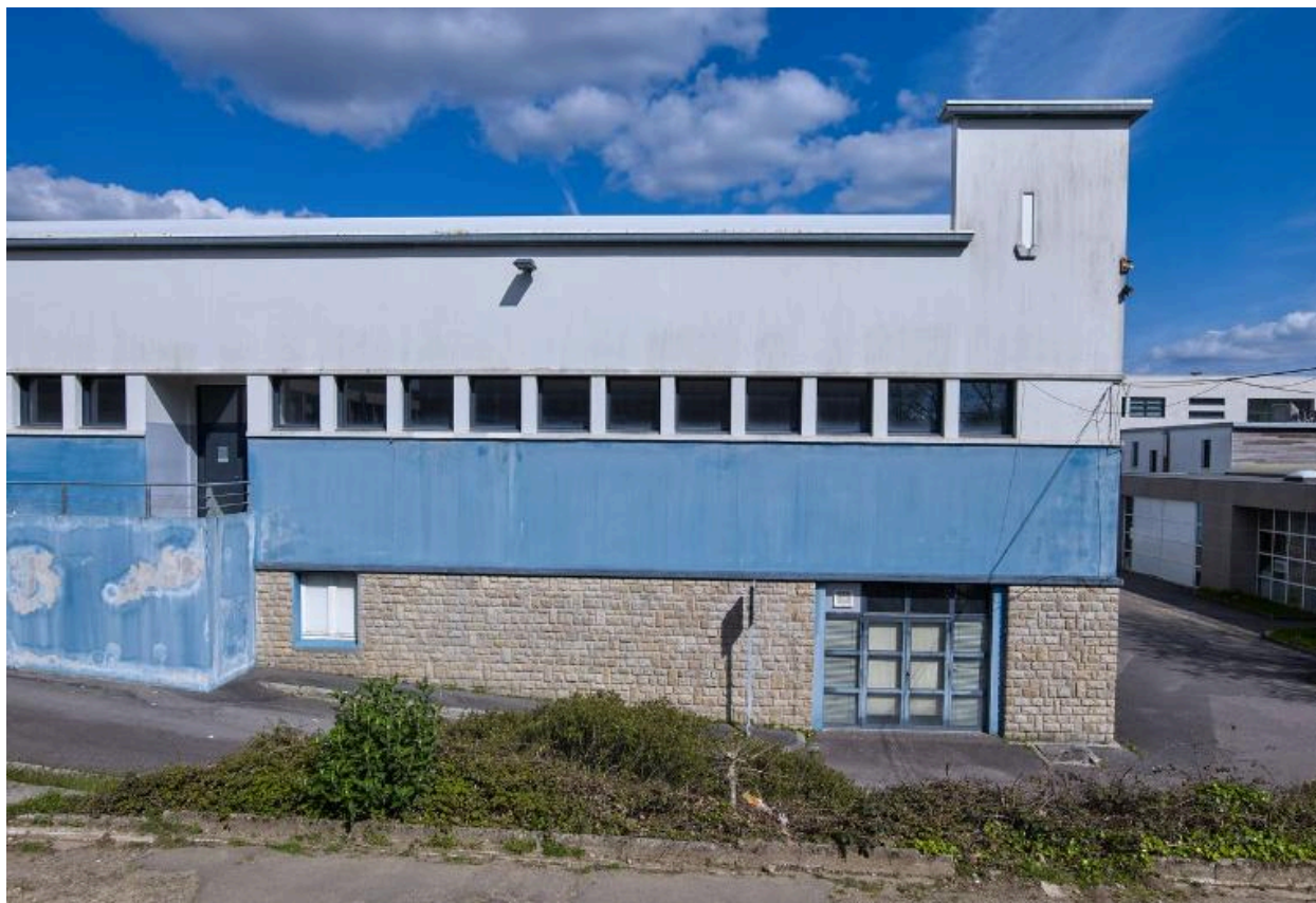
Les ateliers : détail de la façade ouest. J-B. Mathon, architecte.
