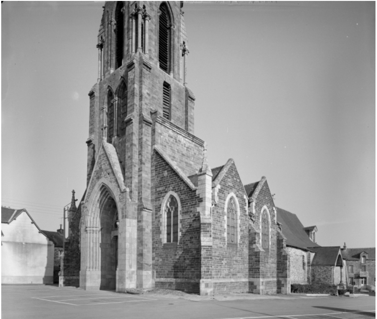
Elévation Sud-Ouest : vue générale
