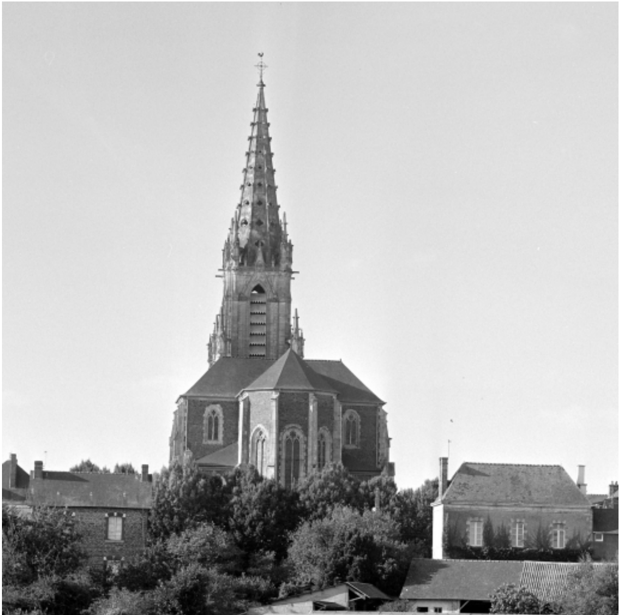
Elévation Est : vue générale (état en 1994).
