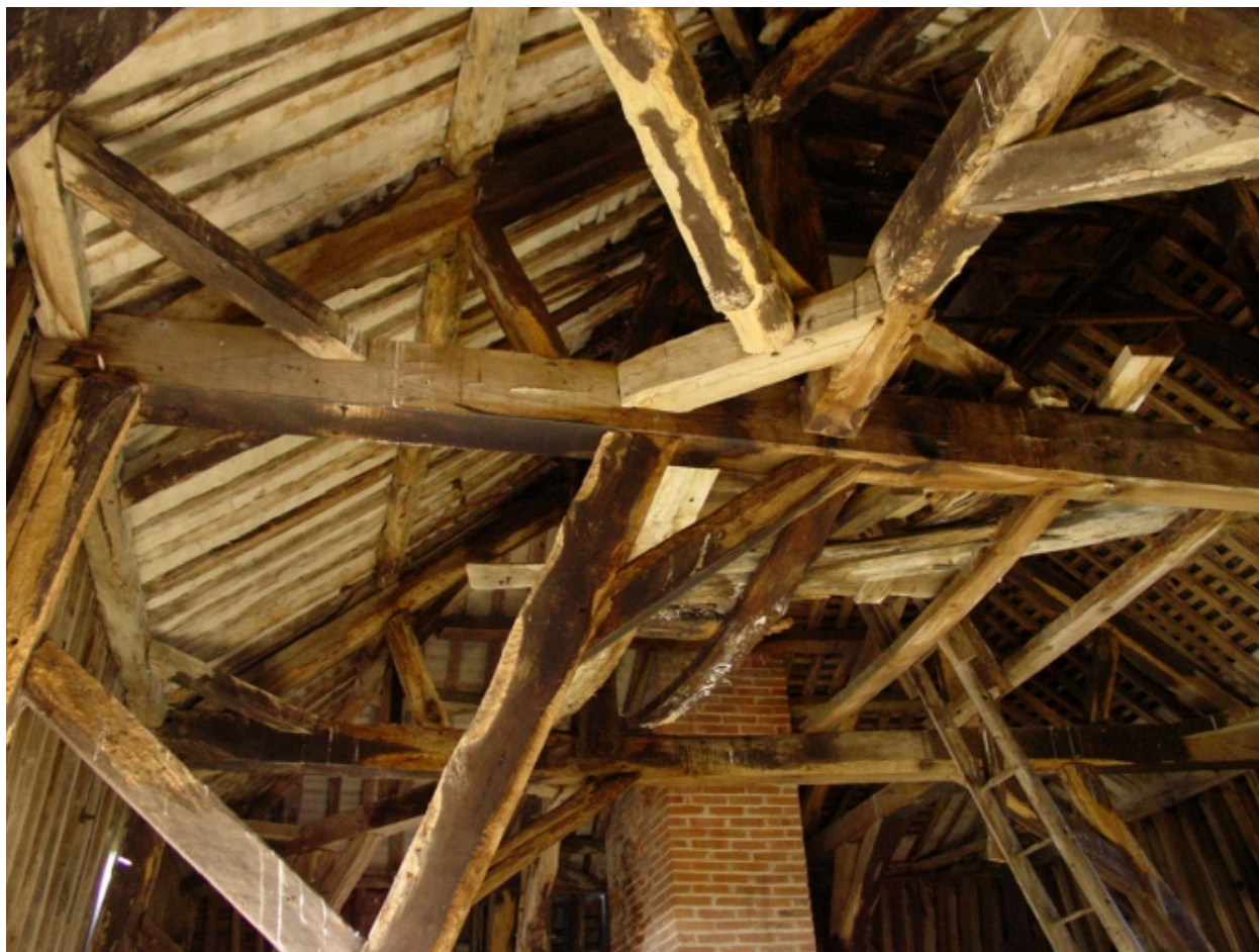
Donjon, détail charpente, partie supérieure.
