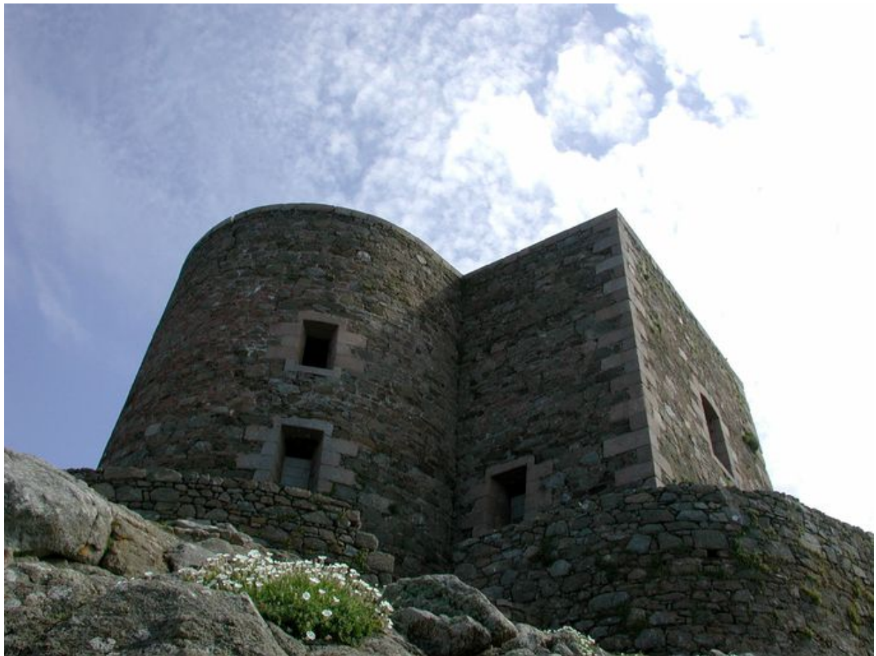
Vue de la redoute de l'Île aux Moines (état en 2002)
