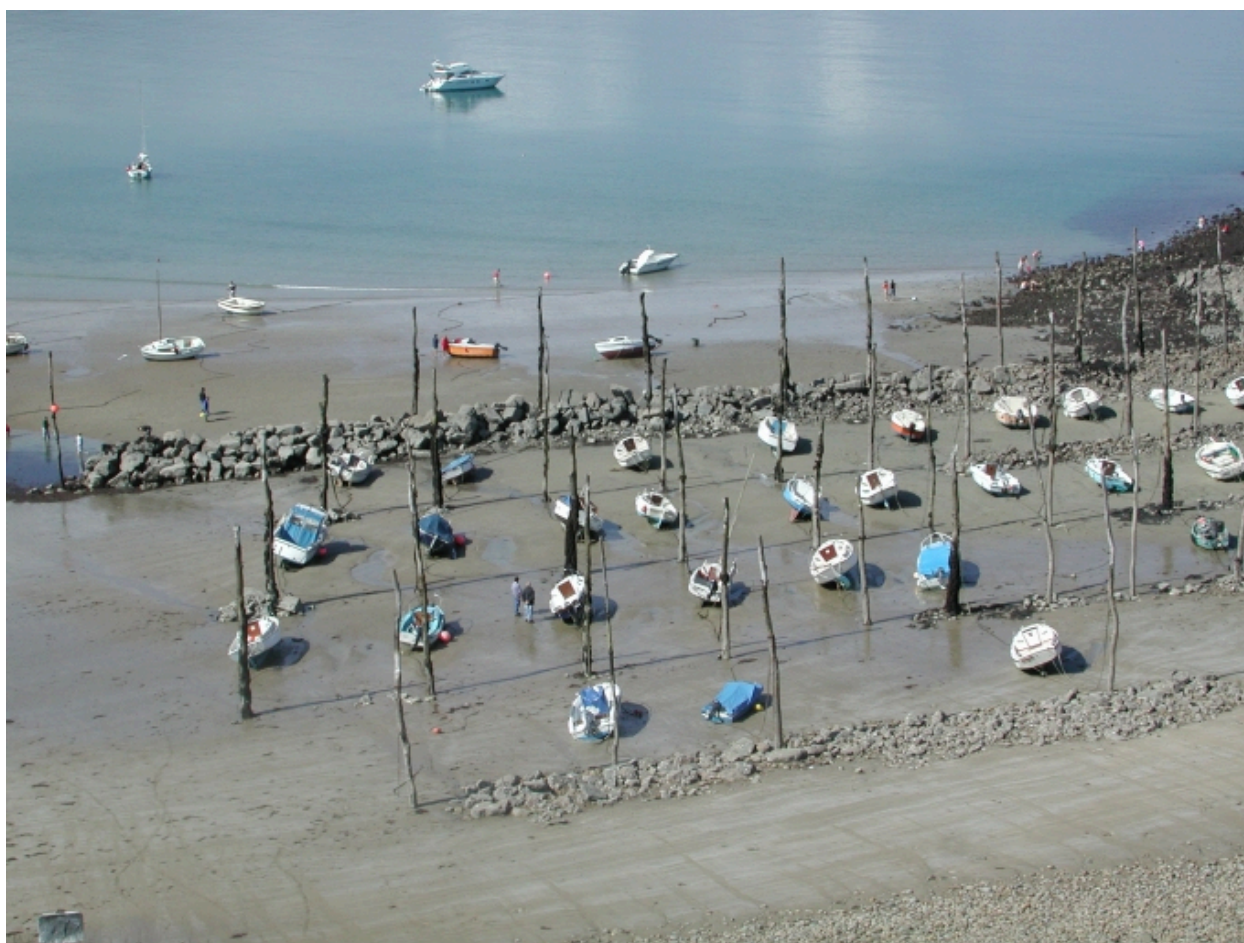
Les 5 rangées de pieux du port de Gwin-Zégal
