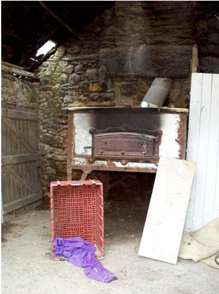
Four en fonte produit en série dans l'ancienne métairie du château : vue générale
