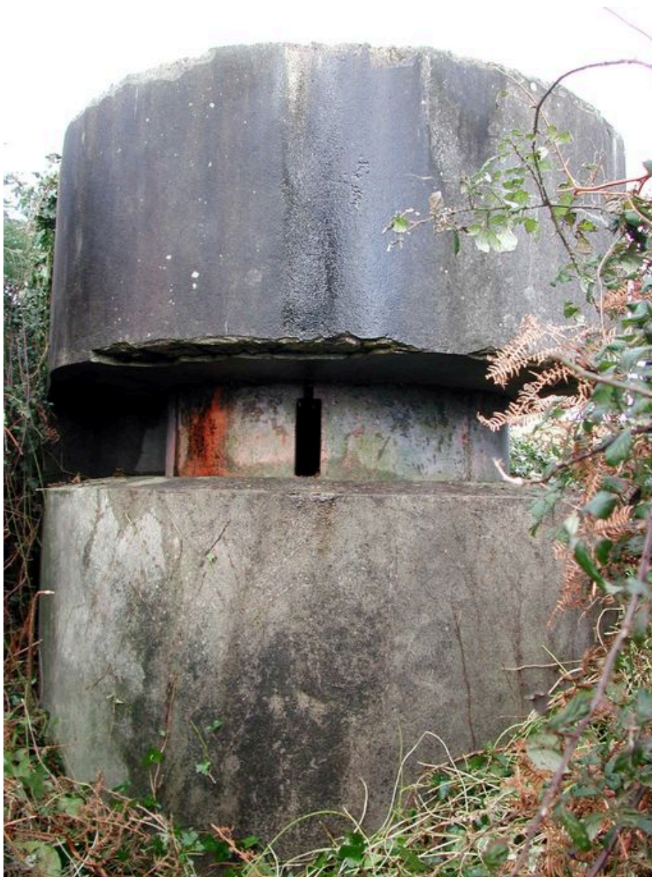
Vue de l'un des postes d'observation et de télémétrie : bâtiment n° 3 (état en 2007)
