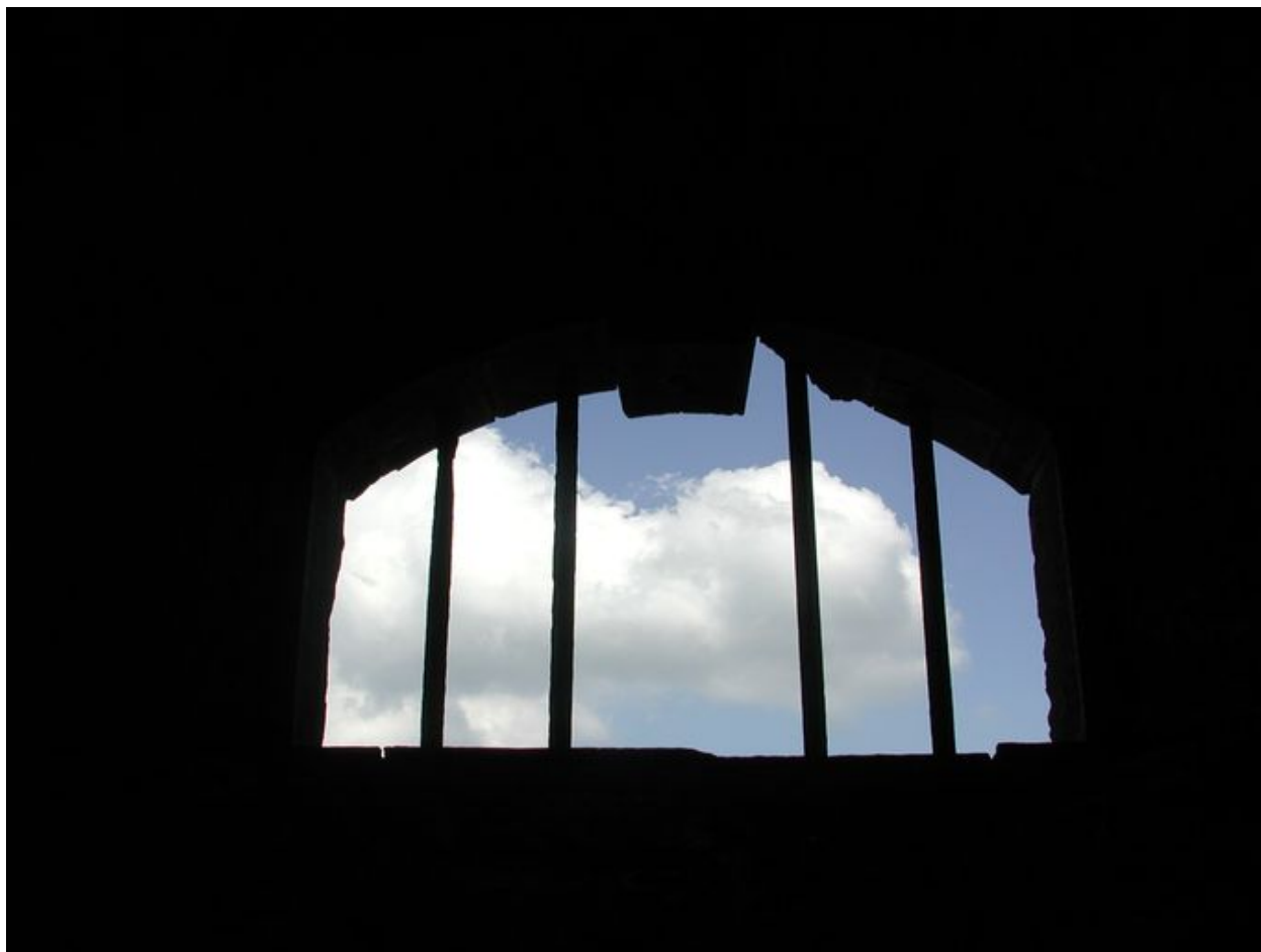
Vue du réduit de batterie de côte de l'île de l'Aber : baie
