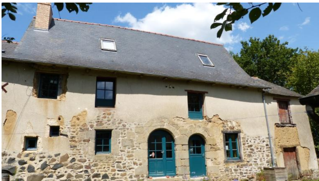
Vue générale, Montdidier (Hédé-Bazouges)
