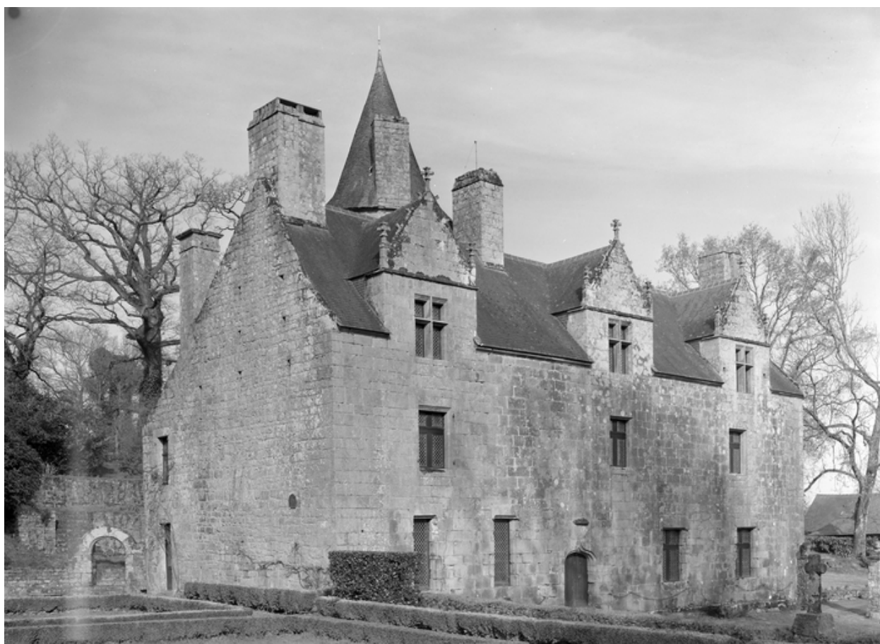
Logis : vue générale de la façade antérieure prise du sud-est.
