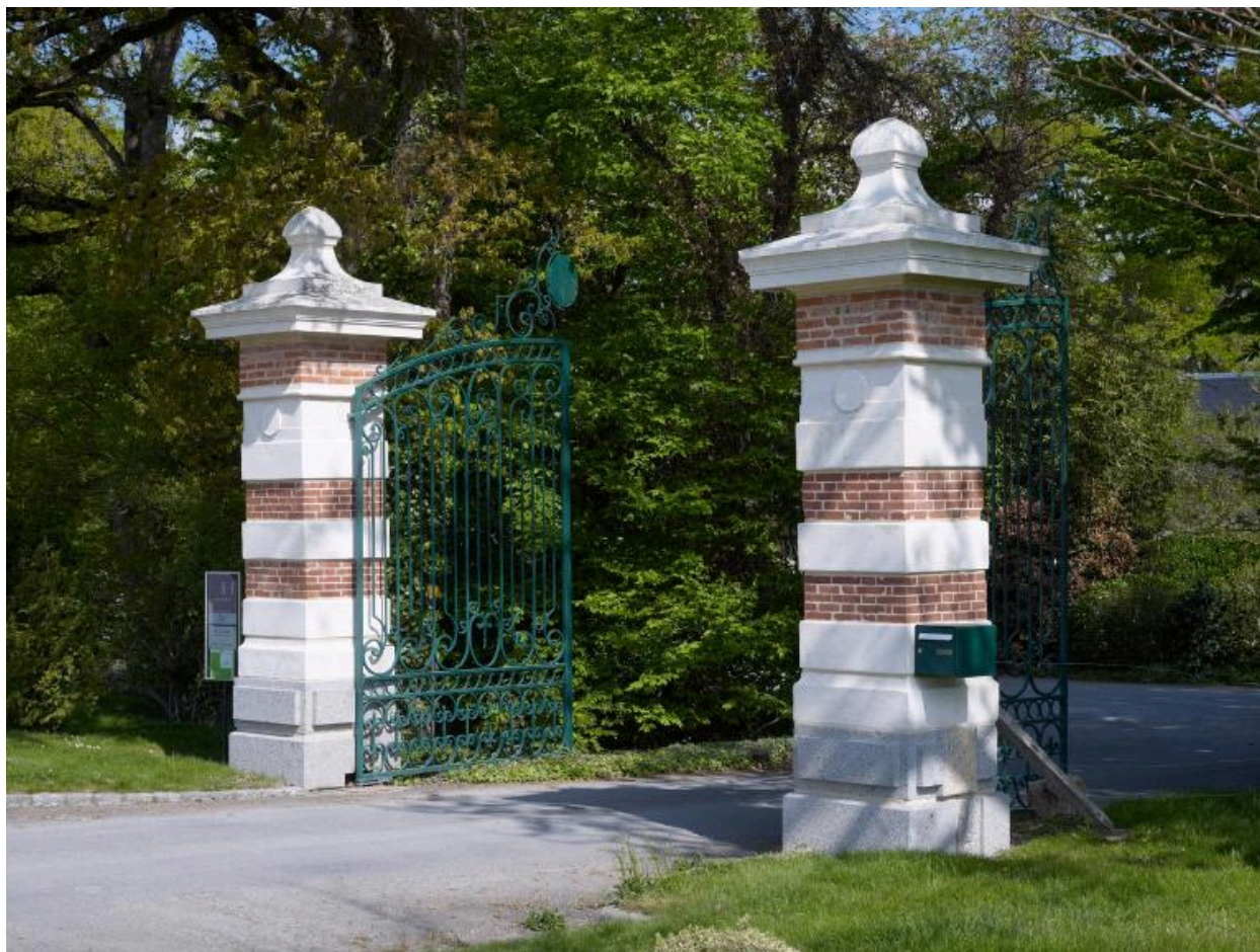
Portail et grille d'entrée du château
