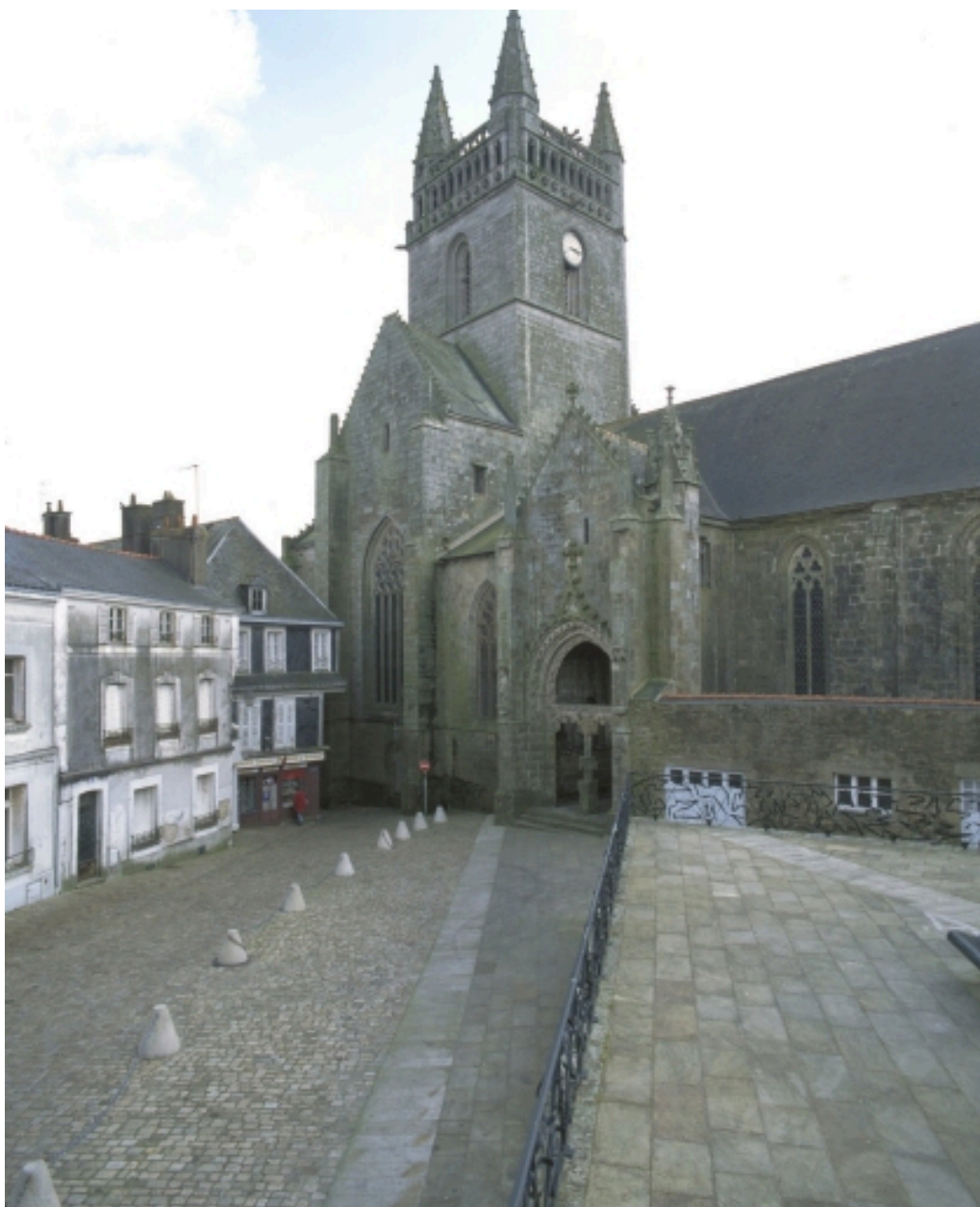
Elévation nord, partie est
