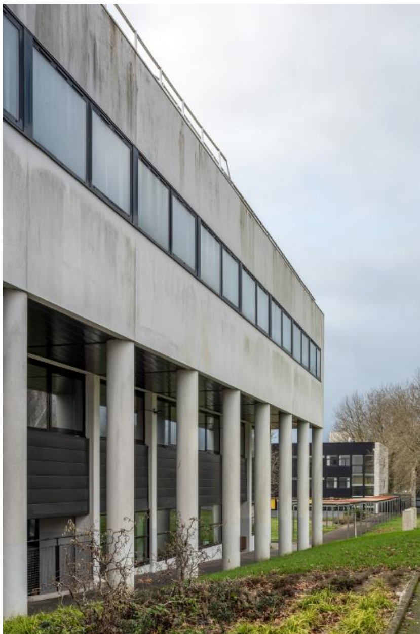
Vue d'ensemble, aile sud du bâtiment multifonctions, façade ouest, galerie couverte et internats (à l'arrière plan).
