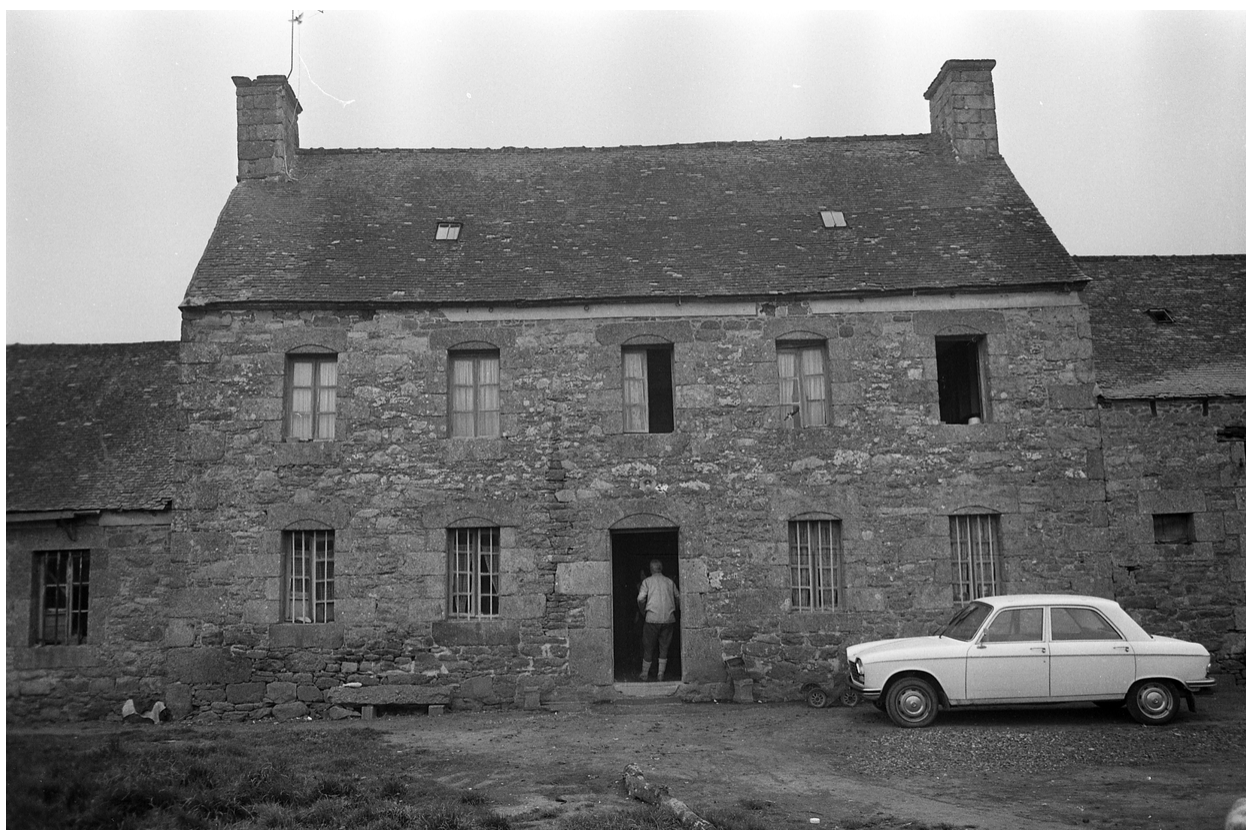
Vue générale de la façade sud
